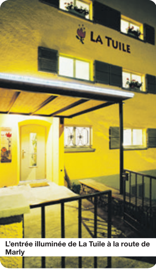
L'entrée illuminée de La Tuile à la route de Marly
