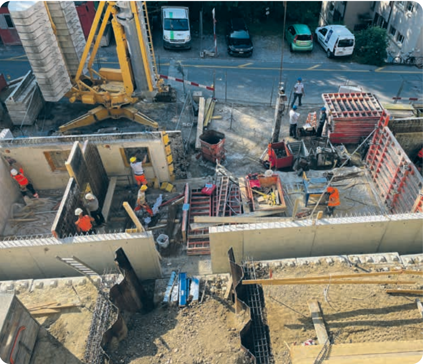
Création du radier et premières parois du nouveau bâtiment.
